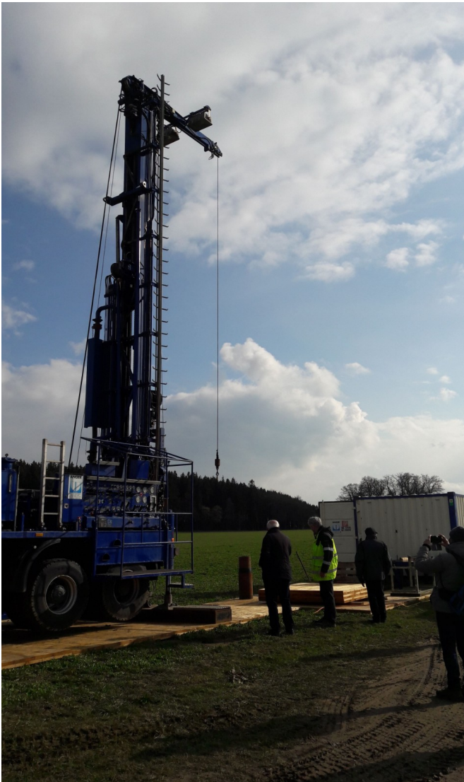
Aufstellen des Bohrturms am 13.04.21
