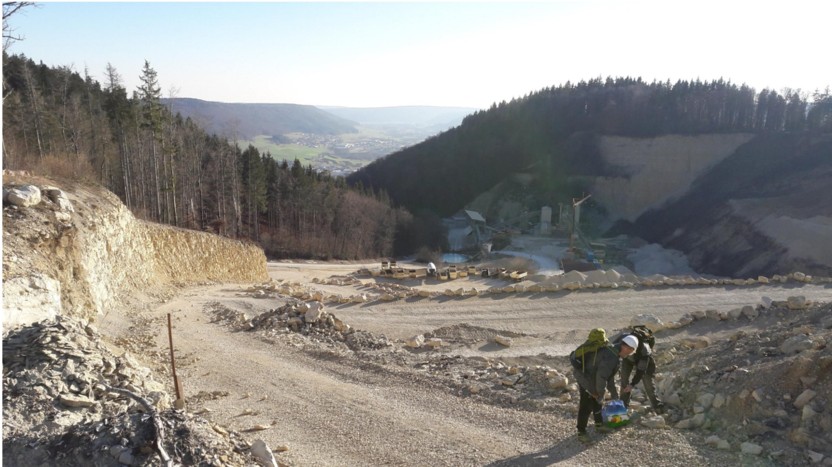
Bild: östliche Einfahrt des Steinbruchs Dürbheim.
